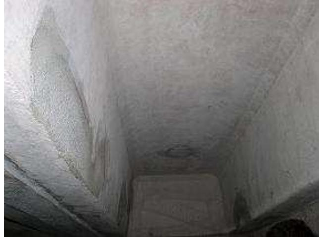
5- Zaštita cjelokupne površine tj. betonske i reprofilirane reparaturnim mortom od utjecaja vlage i atmosferilija vršila se zaštitno-ukrasnim premazom ili hidrofobnom impregnacijom:
