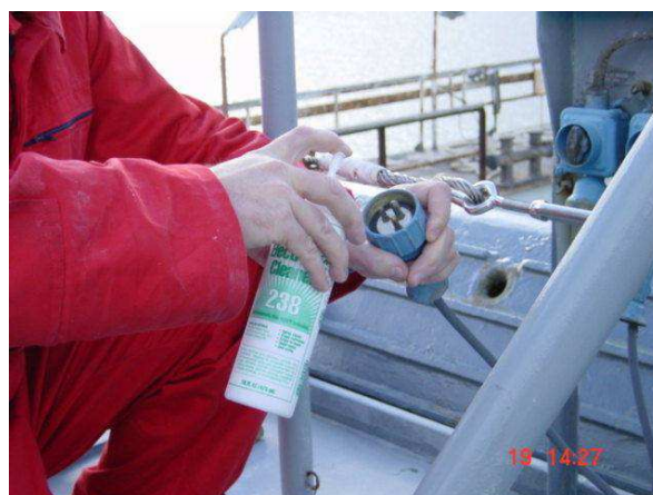
Slika 3.b Primjena inhibitora za zaštitu električnih kontakata [5]
