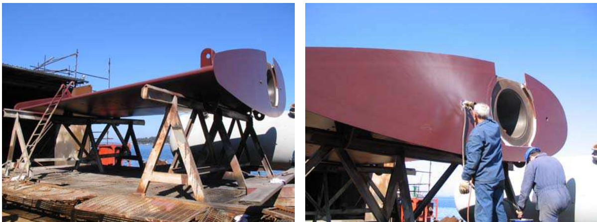
Slika 9. Primjena inhibitora korozije za zaštitu unutrašnjosti lista kormila
