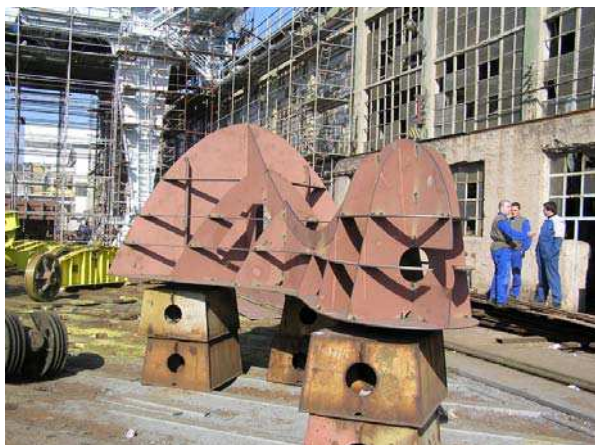
Slika 6.a Unutarnja struktura skulpture u fazi zavarivanja, prije zatvaranja vanjskom oplatom [6]
