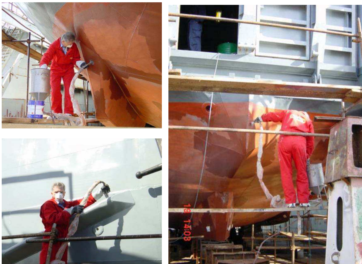
Slika 10. Zaštita kobilice, bokoštitnika i pramca broda praškastim hlapivim inhibitorima korozije [5]
