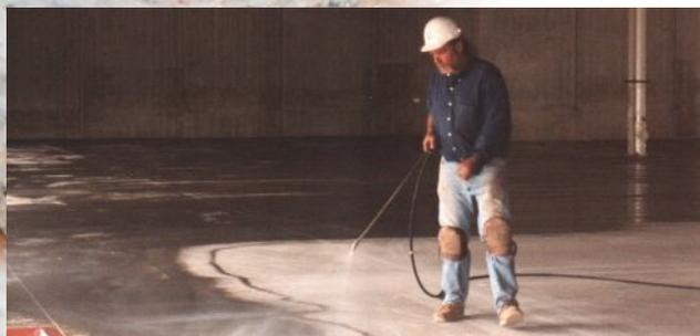
MCI®-2022 je hidrofobna impregnacija na bazi vodene otopine silan-sloxana sa sadržajem migrirajućih inhibitora korozije za zaštitu betona, cementnog morta, opeke, žbuke i drugih građevinskih materijala od oborinske vlage/kiše i atmosferilija a posebice za zaštitu armature od korozije u ab-konstrukcijama.
