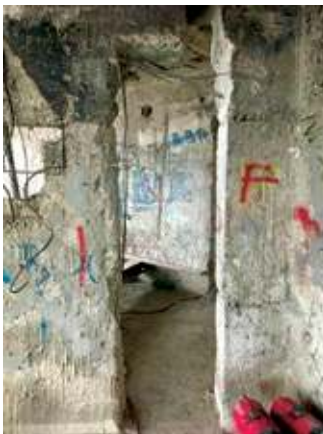
Vertikalne i horizontalne površine prije sanacije i impregnacije
