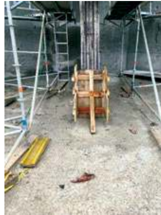
Reprofiliranje AB konstrukcije potpornih stupova
