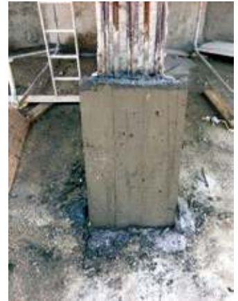
Reprofiliranje AB konstrukcije potpornih stupova
