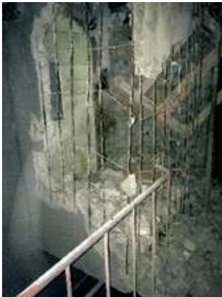
MCI® CorrVerter® na armaturi betona – razne pozicije
