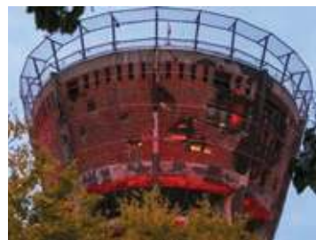
MCI-Arhitectural Coating na dijelu tornja od opeke i AB konstrukcij
