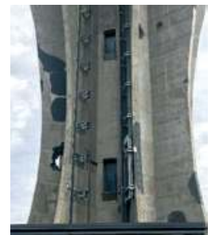
Reprofiliranje AB konstrukcije potpornih stupova
